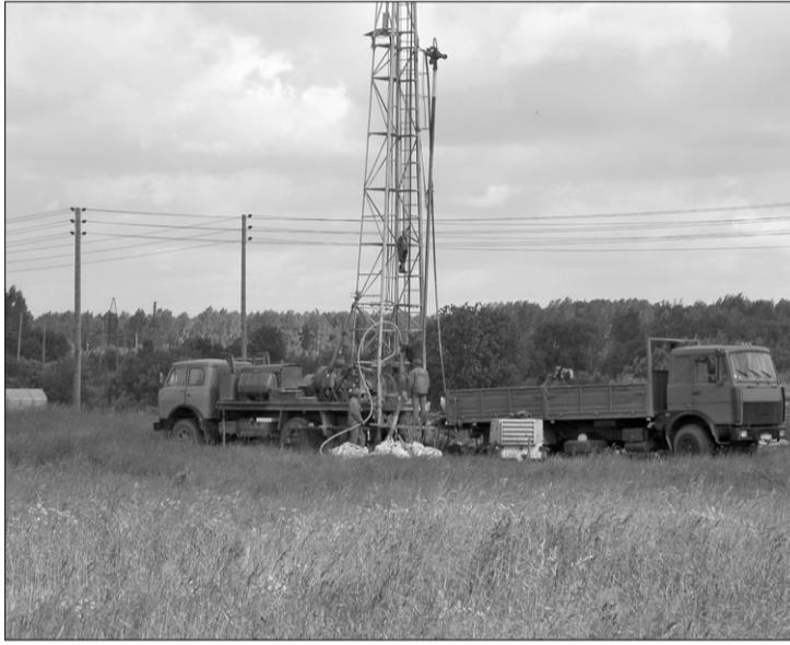
Projekta «Ūdenssaimniecības attīstība Austrumlatvijas upju baseinos» līguma «Dzeramā ūdens sagatavošanas iekārtu izbūve Preiļos» realizācija rit noteiktajos grafikos. Šobrīd notiek jaunu urbumu urbšana un to skalošana. Visi līgumā paredzētie darbi notiek saskaņā ar saskaņotajiem grafikiem. Pēc 2 jauno urbumu izurbšanas tiks sākts ierīkot komunikācijas (ūdens caurules) no urbumu akām līdz stacijai.
