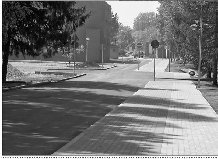
Rekonstruēšanas mērķis bija uzlabot satiksmes drošību. Rekonstruēšanas rezultātā ir nomainītas komunikācijas mezgli, posms ūdensvada, ierīkota lietus kanalizācija, ierīkots apgaismojums, izveidotas ietves, brauktuves, uzklāts asfarts, uzstādītas norobežojošās barjeras, ceļazīmes, horizontālais ielu krāsojums.
