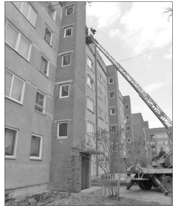
Mājai Celtnieku ielā 11 par uzkrātajiem apsaimniekošanas līdzekļiem maina kāpņu telpu logus.
