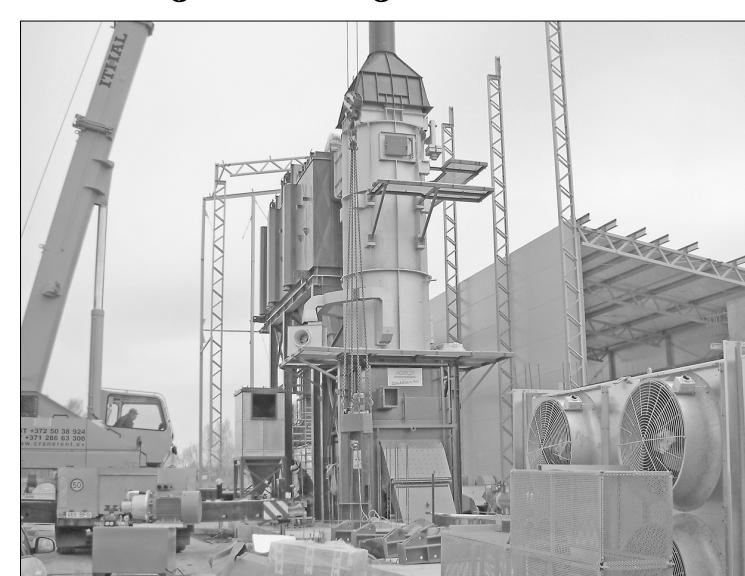
Kā pastāstīja jaunās koģenerācijas stacijas vadītājs Pauls Vaivods, šobrīd ir uzstādītas galvenās iekārtas – šķeldas kurtuve, termoeļļas katls un ORC turbīna. Minētās iekārtas nav obligāti ie-būvēt zem jumta, bet neraugoties uz to, ka sadārdzinās izmaksas, Preiļos tas tiek darīts, lai slāpētu troksņu līmeni.
