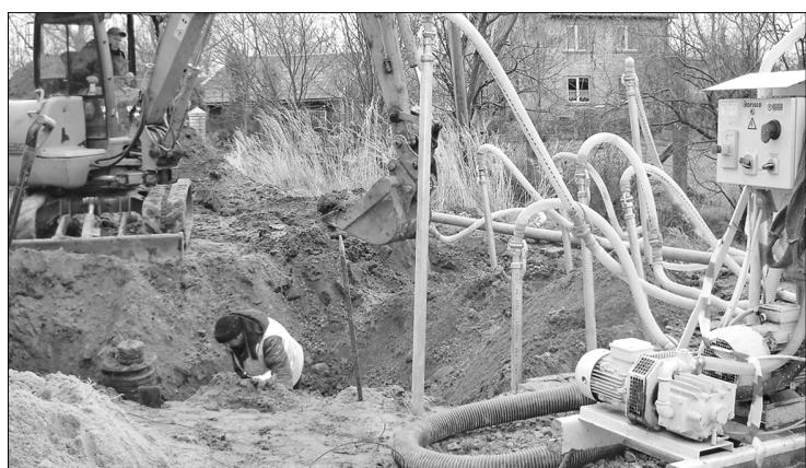
**Строительство магистрального водопровода и канализационных сетей по улице Берзу уже закончено, сейчас монтируются колодцы подключения (на снимке). Это одна из тех улиц, где высокий уровень грунтовых вод усложняет строительные работы, поэтому используется специальное откачивающее воду оборудование. Жители улицы Берзу уже в скором будущем смогут подключить свои дома к построенным сетям и использовать все преимущества системы центрального водоснабжения и канализации.**
