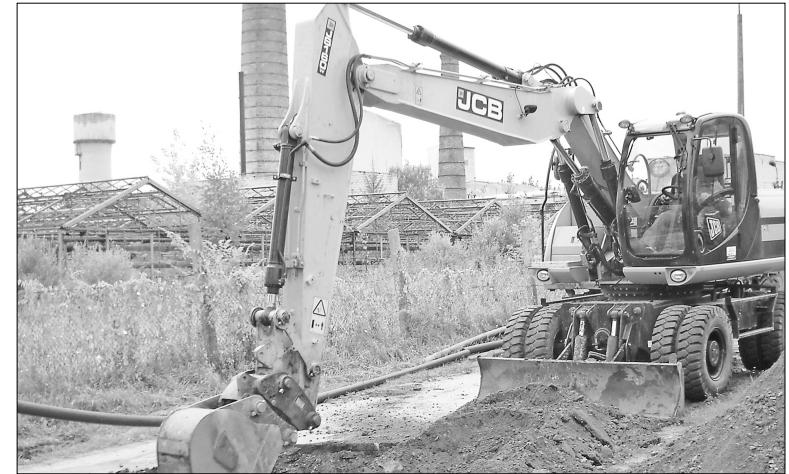
На снимке: на улице Салтупес проводятся работы по строительству магистрального водопровода.
