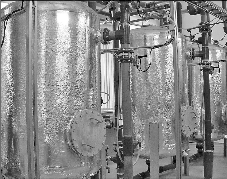
Attēlā – dzeramā ūdens atdzelzošanas iekārtas Rēzeknes ielā darbojas automātiskā režīmā, un rezultātā maģistrālajos ūdensvados nonāk tīrs, normām atbilstošs dzeramais ūdens.
